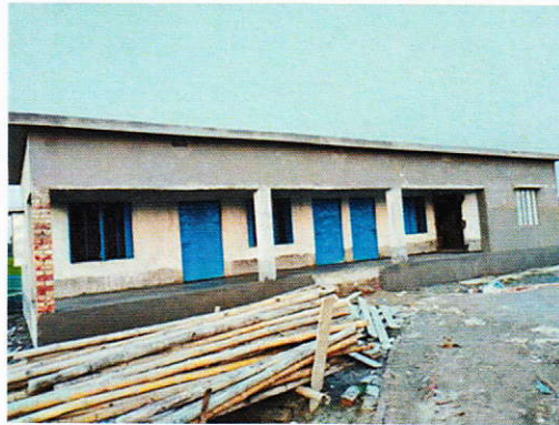
Il nuovo edificio scolastico è quasi terminato
