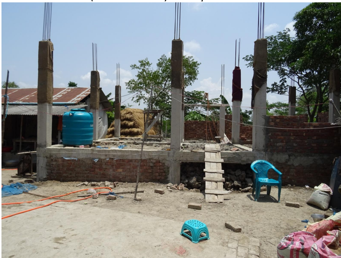
La casa (in costruzione) del capomastro Romesh
