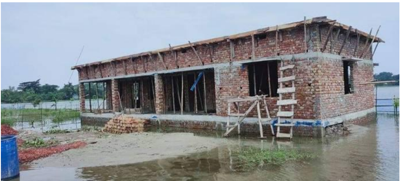
La scuola in costruzione alla Probashi Para.
