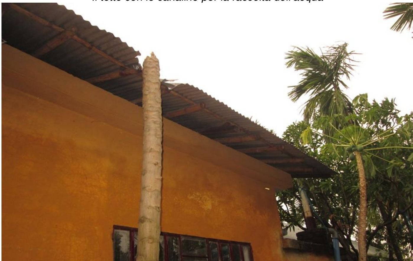
Il tetto con le canaline per la raccolta dell'acqua
